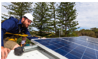
СОНЯЧНА ЕЛЕКТРОСТАНЦІЯ ООО «МІІА ГРУП» Дніпро 2019
