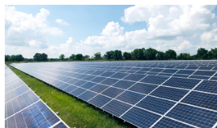
СОНЯЧНА ЕЛЕКТРОСТАНЦІЯ ООО «Сонячна брама» Івано-Франківська обл. 2018
