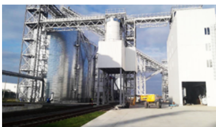
РЕКОНСТРУКЦІЯ: СУШИЛЬНИЙ ЦЕХ ООО «УХЛК» Житомирська обл. 2018
